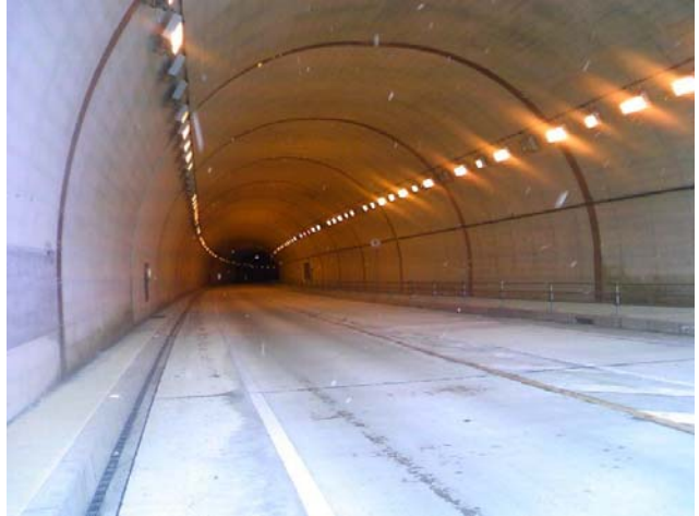
照明設備と消費電力を削減 【トンネル（広島県三原町）】
