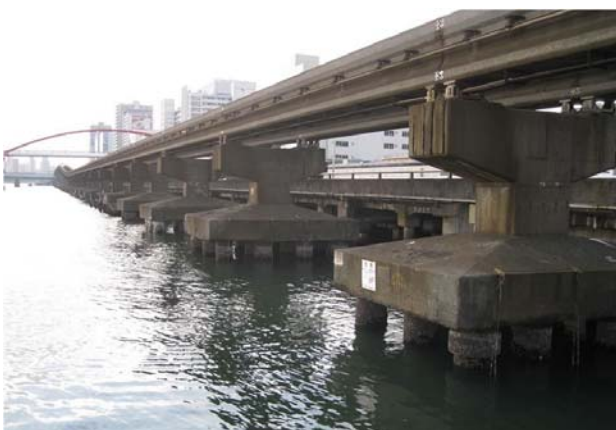
対象構造物（施工前）
